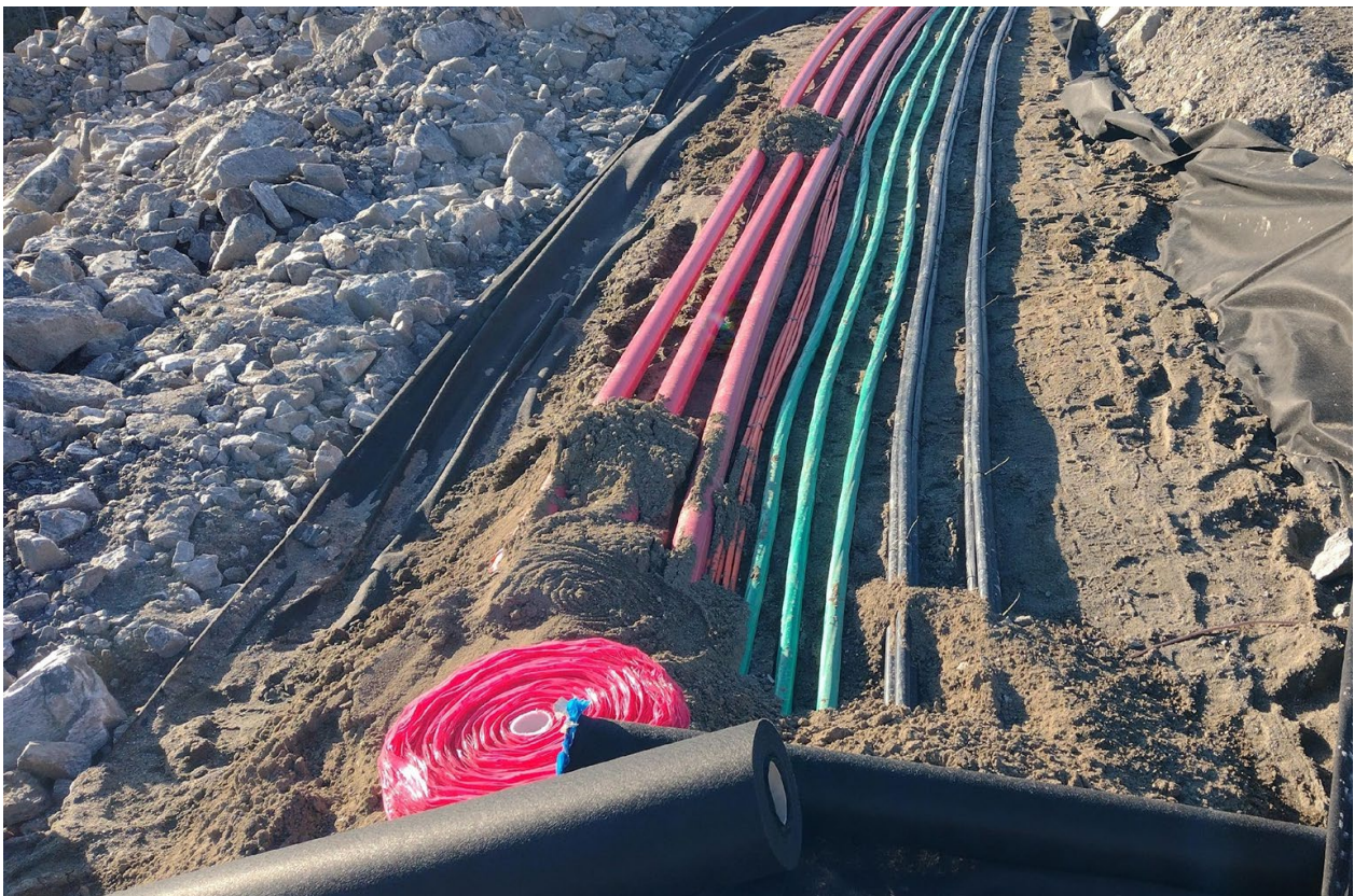
Ulike typar kablar til eit nytt byggefelt.
